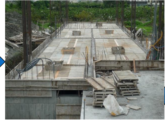
各槽檢修井灌漿完成
