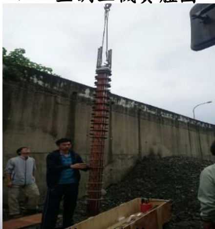
金屬熱交換管放置
