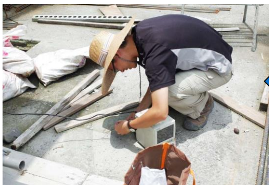
量測設備安裝
