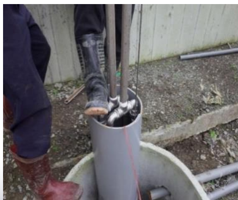
出入水管安裝
