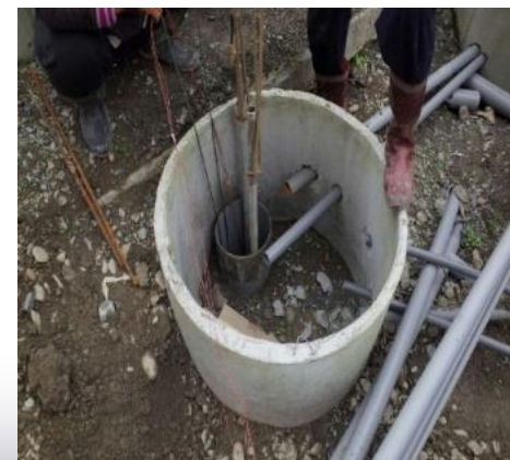
金屬熱交換器放入井中
