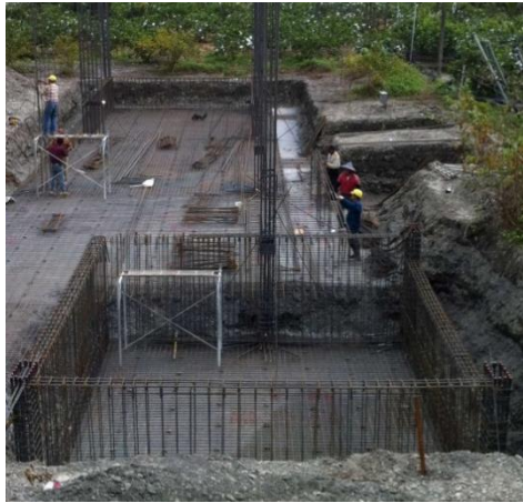
筏基結構工程施工
