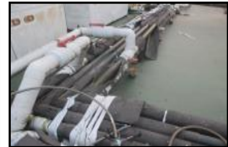
保溫材脫落，降低冰水效率
