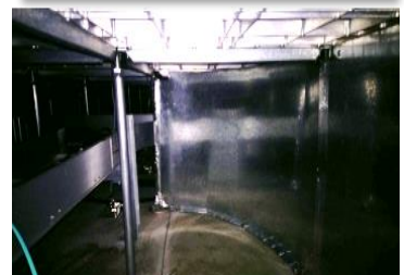
高架地板下加設導風板
